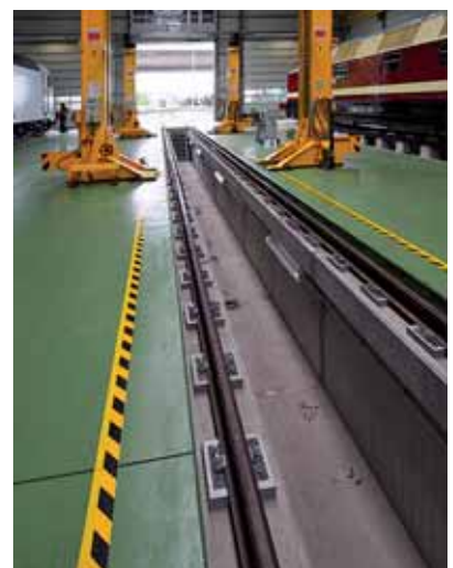
Arbeitsgruben nach der Fertigstellung
