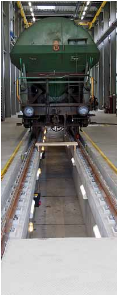
Speziell für den Werkstattbereich müssen Betonfertigteile dicht und undurchlässig für wassergefährdende Schadstoffe sein.
