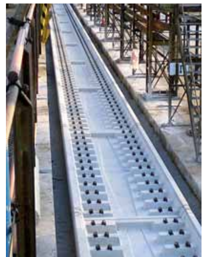
Gleistragwannen bei der Montage
