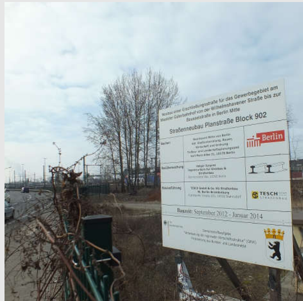
Baustellenschild Erschließung Straße für das Gewerbegebiet (ehemaliger) Moabiter Güterbahnhof
